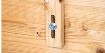
Sturmleiste bei Wandstärken 28 und 40 mm
