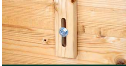
Sturmleiste bei Wandstärken 28, 40 und 44 mm
