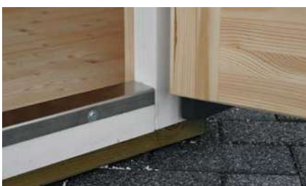
Isolierverglaste Leimholz-Türen mit Metall-Türschwelle
