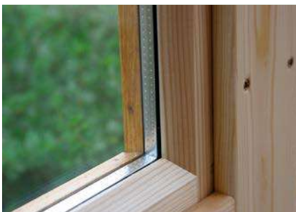
Isolierverglaste Leimholz-Fenster
