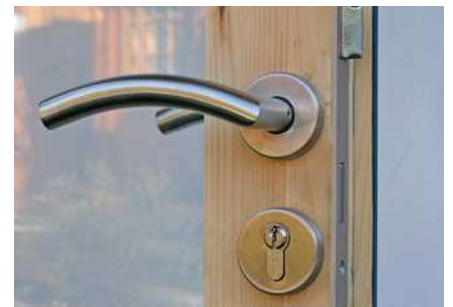
Edelstahl-Türbeschlag und Zylinderschloss
